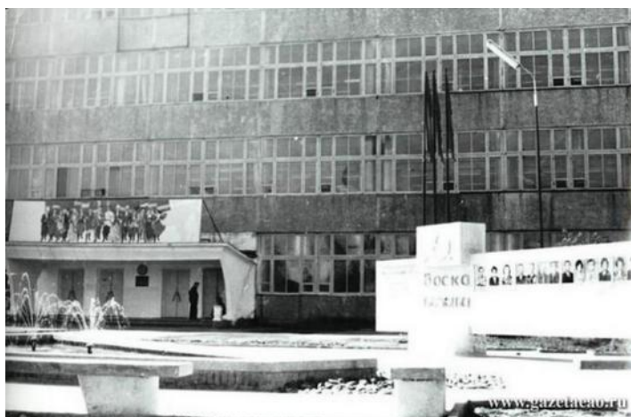
Рис. 47. Здание Биробиджанской обувной фабрики
